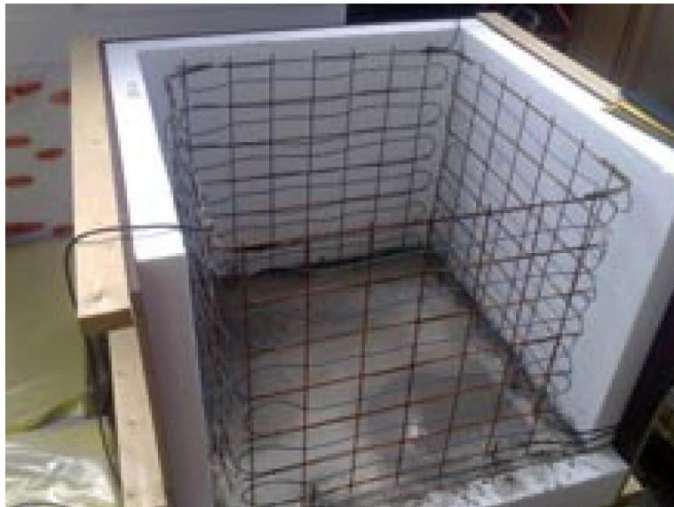
Figur 4. En värmekabel är inflätad i armeringsnätet för att påskynda uttorkningen av betongen. Foto CBInytt 1-2013 [4]
