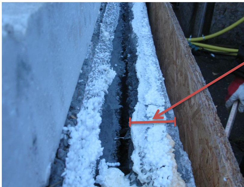
Figur 6. Isoleringen som endast var 3 cm tjock på sina ställen byttes ut den 13 mars 2015.
